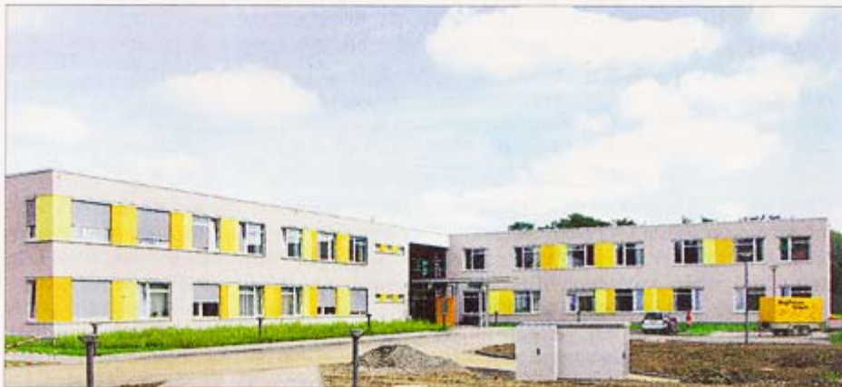
Der zweiflügelige Gebäudekomplex am Ende des Klinikgeländes beherbergt links das Sozialpädiatrische Zentrum und rechts die Kinder- und Jugendpsychiatrie (Tagesklinik).
